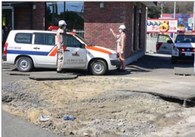
緊急自動車による巡回点検実施
